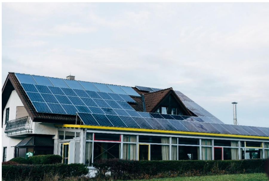
Figura 35. Estrutura de sustentação sobre a edificação
